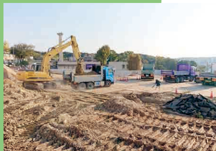
天白区植田山 造成工事
