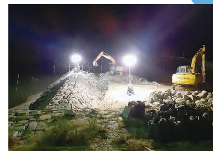
吉良吉田 被覆石復旧夜間工事
