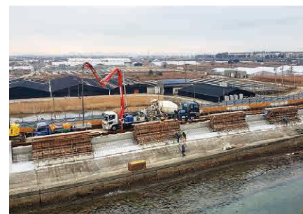
一色町坂田 耐震工事
