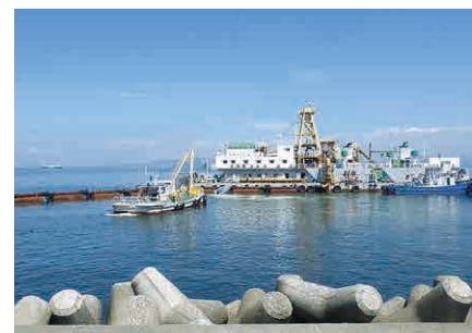
漁港修築工事（機能保全）浚渫工
