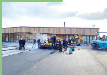
憩の農園 外構工事
