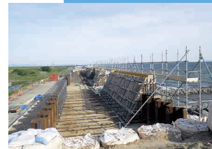
一色町生田 耐震工事
