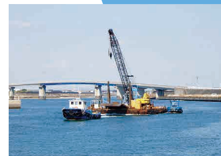
ゲート台船運搬作業
