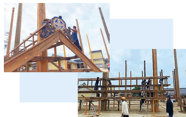
一色大提灯祭り 土台取付
