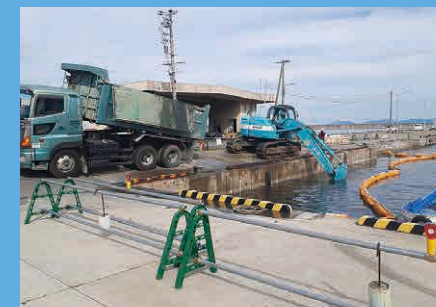
鳥羽町 物揚場補修工事
