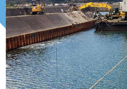
西幡豆 護岸工事
