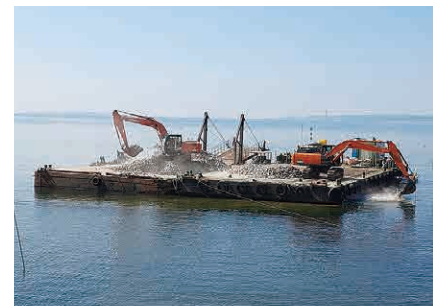
貝類増殖場造成工事
