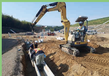
西尾造成工事
