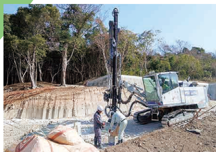
道路改良工事 静的破碎工（佐久島）
